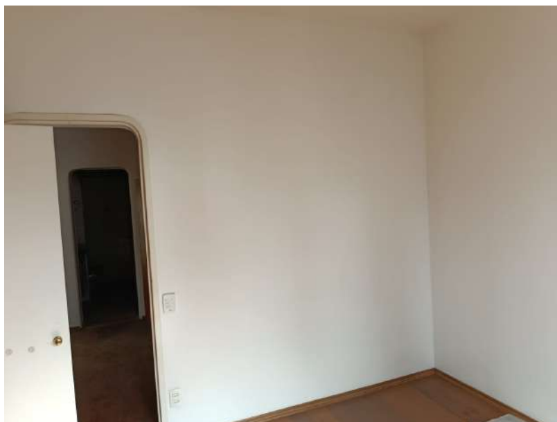
Foto 36 - Detalhe - Quarto Piso Laminado
