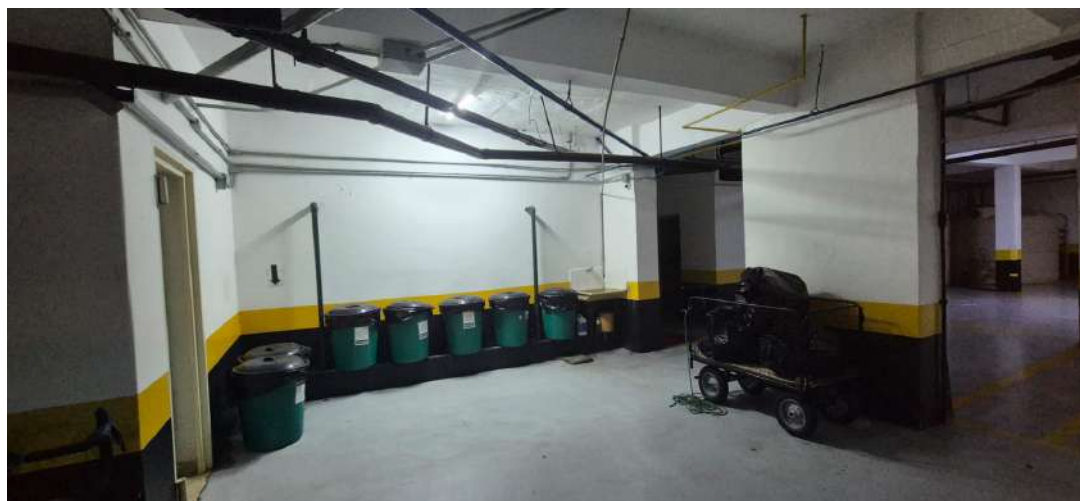
Foto 19 - Garagem - Área de Reciclagem
