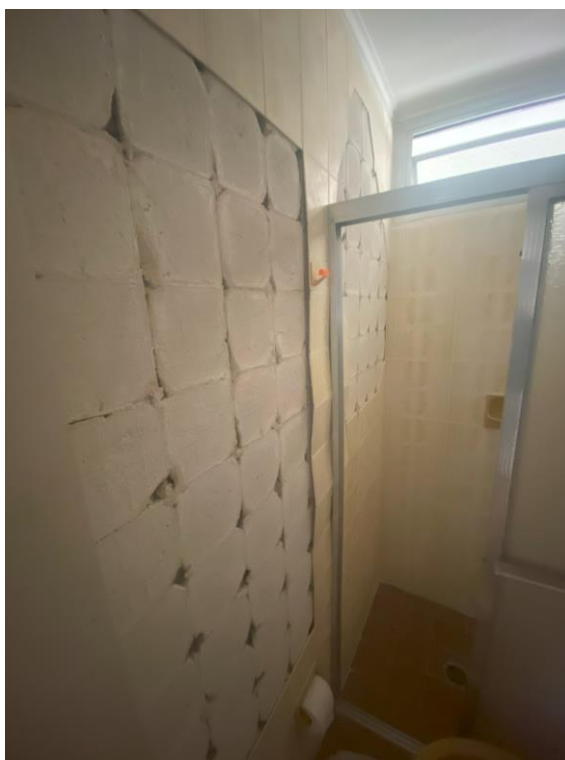
VISTA DO AZULEJO DO PRIMEIRO BANHEIRO.
