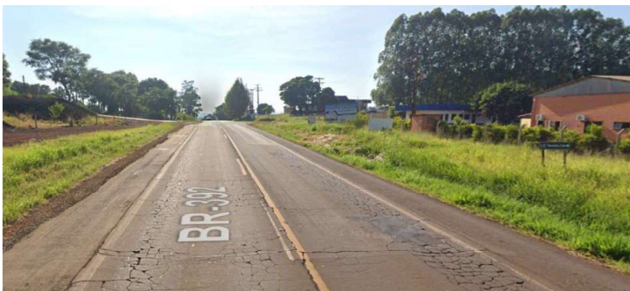
DETALHES DA VIA DE ACESSO AO IMÓVEL
