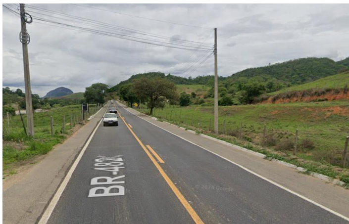
DETALHES DA VIA DE ACESSO AO IMÓVEL
