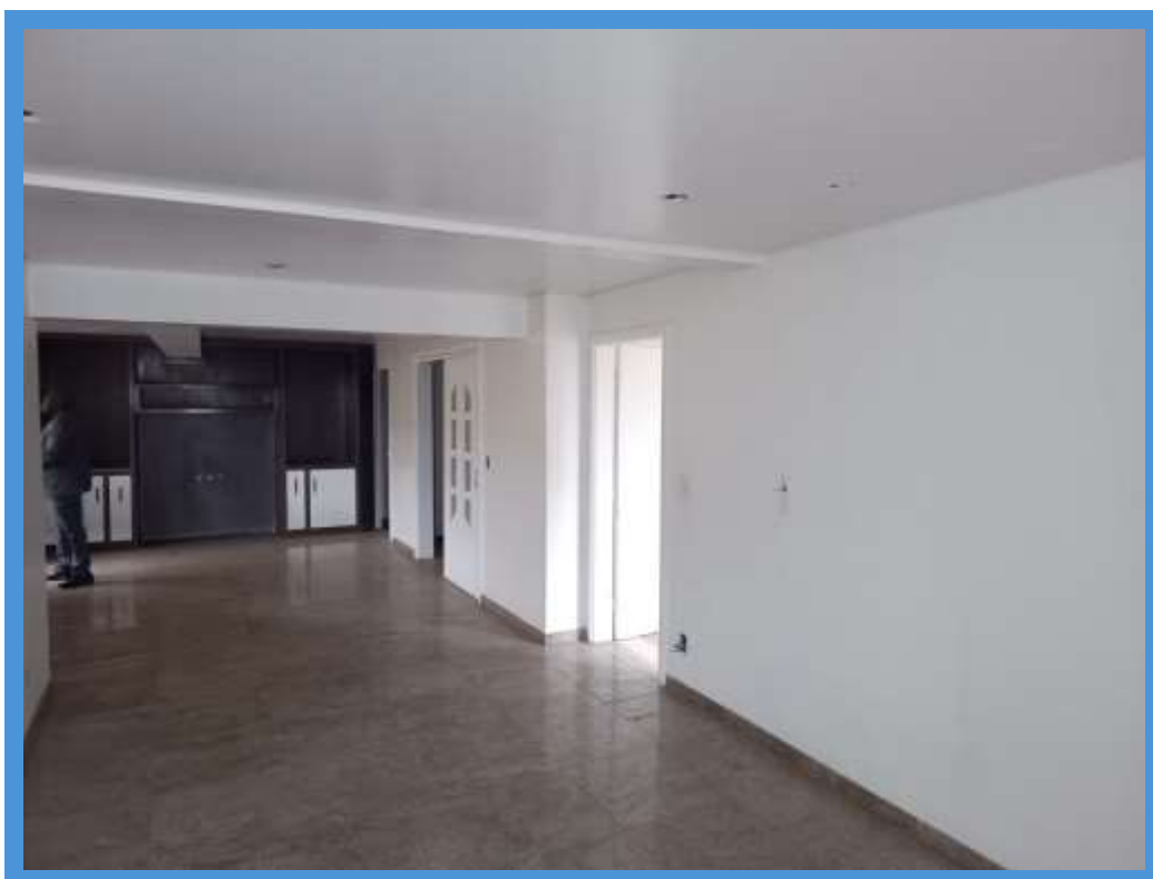
VISTA DA COBERTURA.
