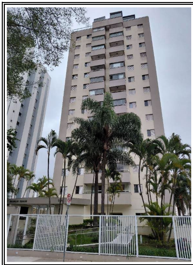
Foto nº 01: Vista geral do Edifício Brooklin Square
