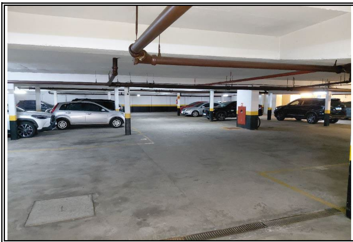
Foto nº 21: Vista da garagem no subsolo do Edifício Brooklin Square
