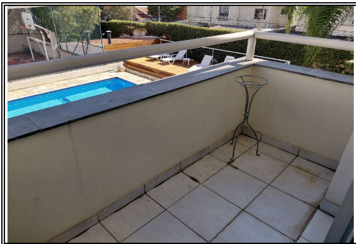
Foto nº 09: Detalhe da sacada
