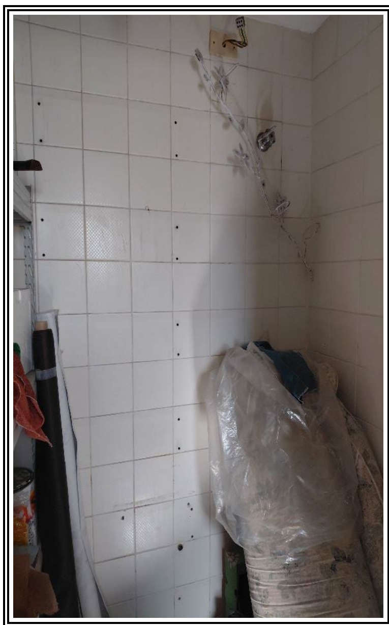
Foto nº 19: Vista do banheiro de serviço
