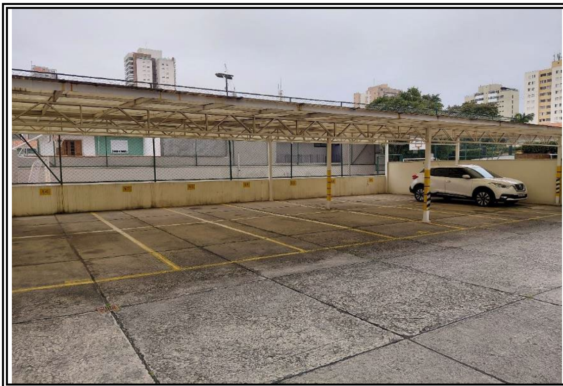
Foto nº 20: Vista da garagem no pavimento térreo do Edifício Brooklin Square
