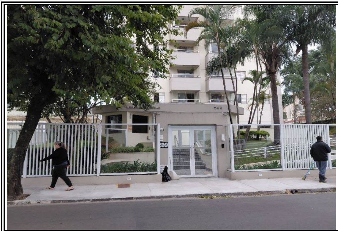
Foto nº 04: Vista da entrada do Edifício Brooklin Square
