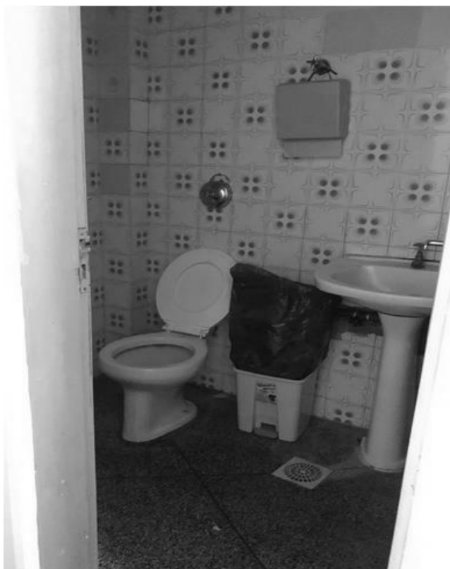
(Banheiro na sobreloja)
