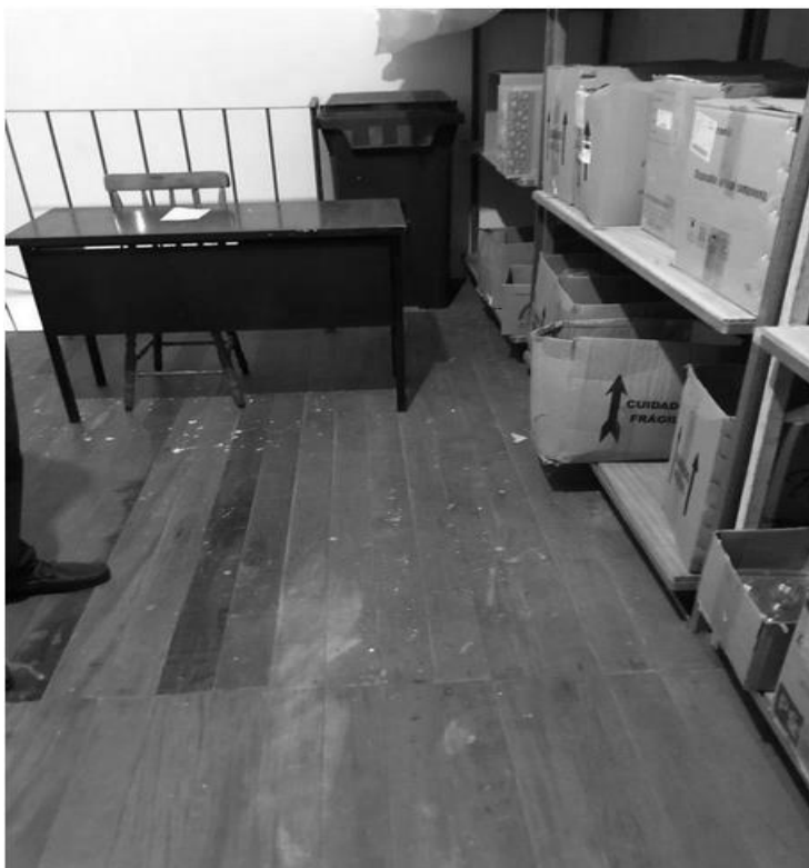
(Sobreloja – piso madeira)
